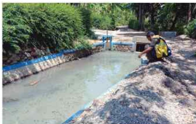
DPUPR Ngawi siap mendukung pembangunan infrastruktur pertanian termasuk jaringan irigasi persawahan.
