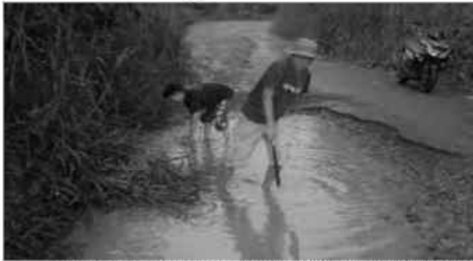
Kondisi jalan milik Provinsi yang kondisinya semakin parah dan tak pernah dilakukan perbaikan. JERI/RB-
