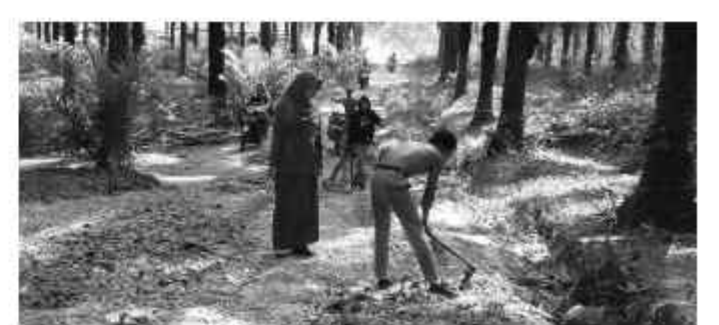
Kepsek SMKN 1 Silangkitang bersama siswa sedang bergotong royong memperbaiki jalan
