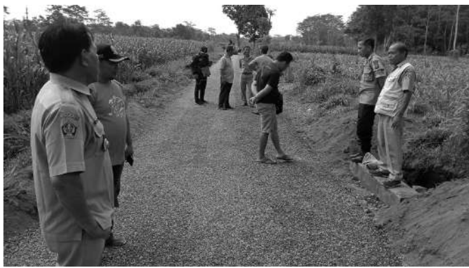
Kepala Desa Kendalrejo Ahmadi Soefanan saat mengecek pembangunan jalan usaha tani
