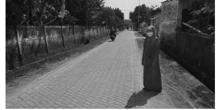
Perangkat Desa Banjarsari Kecamatan Madiun Kabupaten Madiun tinjau proyek pavingisasi jalan desa di Dusun Kepel RT 04 RW 01
