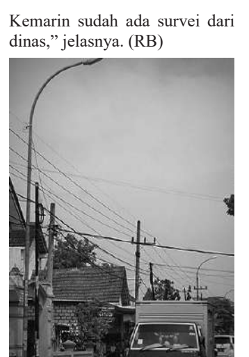
Jalan di Desa Tanjungharjo ini sudah dipasang lampu penerangan jalan umum (PJU)
