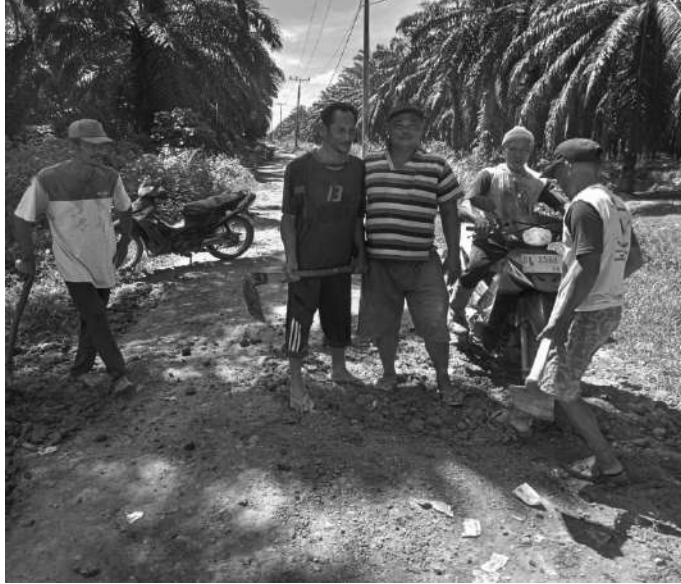
Warga saat gotong royong memperbaiki jalan lintas Ulak Kuba
