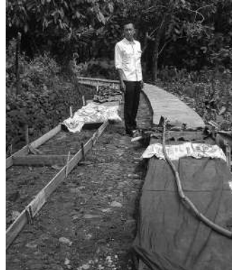
Perangkat Desa Morang meninjau pembangunan rabat jalan desa Morang di RT 17 di dusun Kepak
