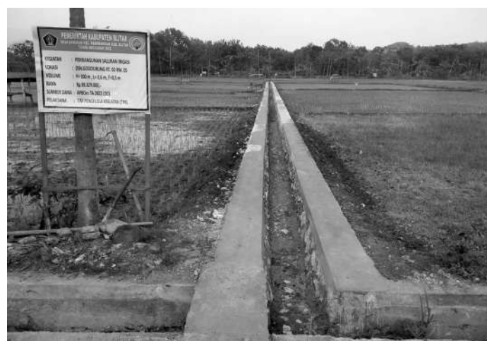
Pembangunan saluran irigasi di Desa Dawuhan, Kecamatan Kademangan
